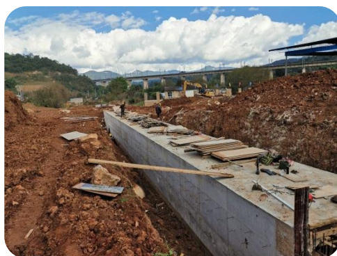
施工中的农灌渠
